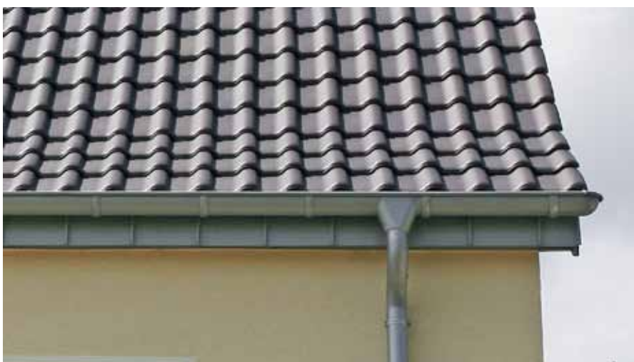
Ein Rückbau der Gesimsbekleidung aus Zinkscharen aufgrund der aus Sicht des Auftraggebers nicht gleichmäßigen Aufteilung der Scharenbreite wäre unverhältnismäßig.
