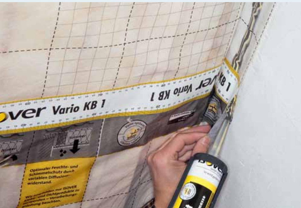
Glatte und saubere Untergründe sind die Basis für Anschlüsse in Wandbereichen.
