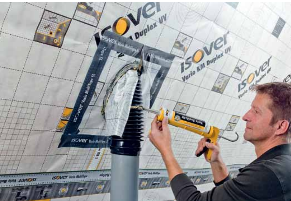
Strukturierte Durchdringungen erfordern bei der Erstellung eines luftdichten Anschlusses viel Geschick und systemkompatible Materialien.
