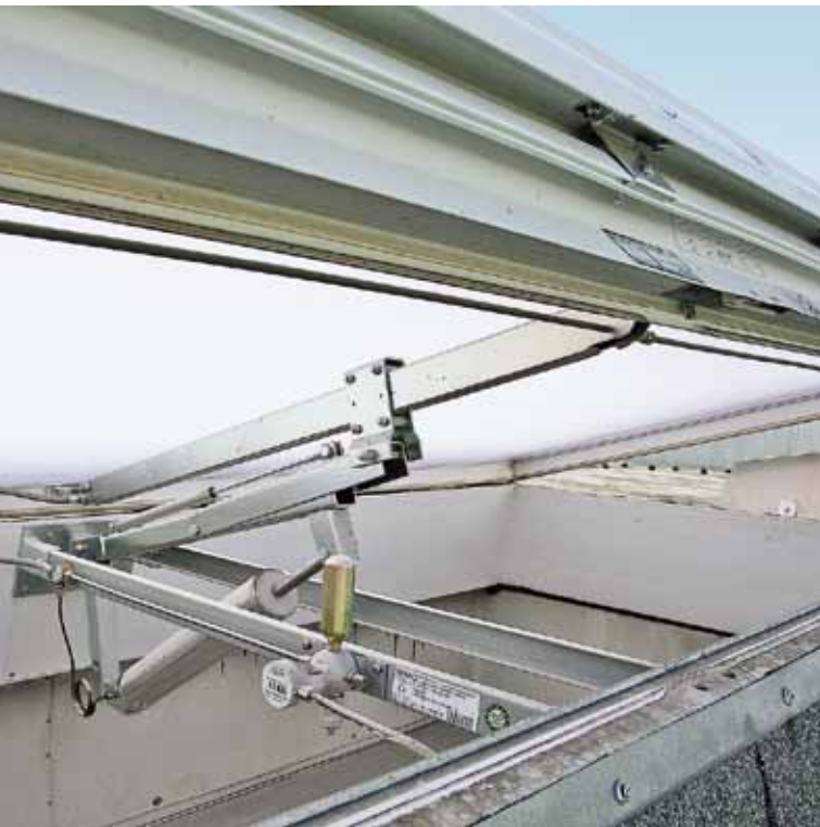
Auf die vorhandenen beschädigten Lichtkuppeln montierten die Handwerker neue zweischalige Lichtkuppeln.
