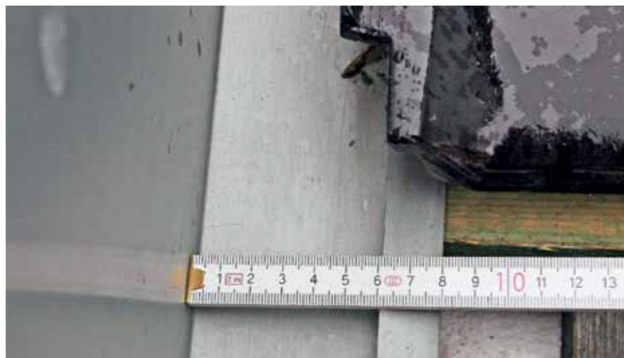
Der unterliegende Metallanschluss weist eine Gesamtbreite von 80 mm auf, wobei die Dachziegel das Blech mit circa 40 mm überdecken – beides ist unzureichend.
